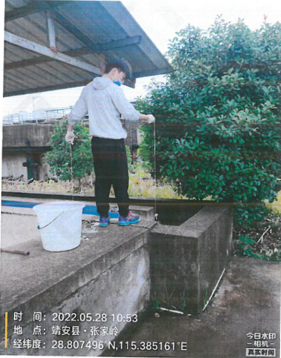
工业园污水处理厂出口
